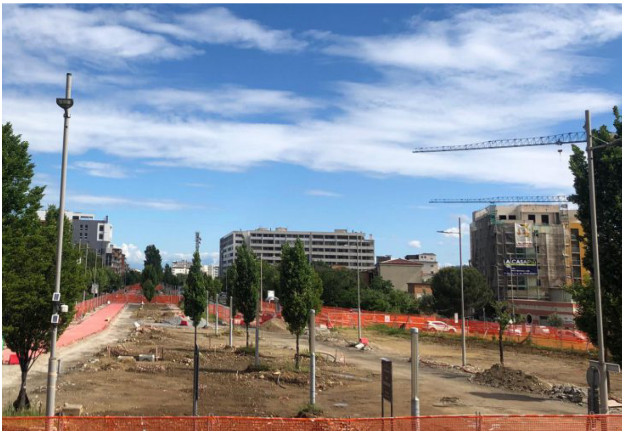
Immagine del cantiere per la realizzazione del Parco del Benessere (viale Giacomo Mancini)
