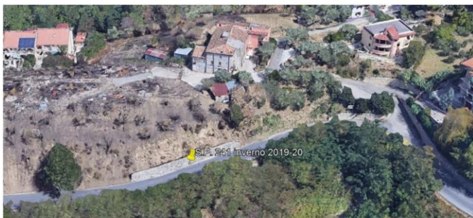
S.P. 241 piccoli crolli verificatesi nell'inverno 2019-2020
