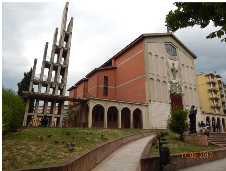
Foto del complesso parrocchiale - vista lato Nord-Ovest
