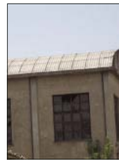
Uno dei tetti in eternit
