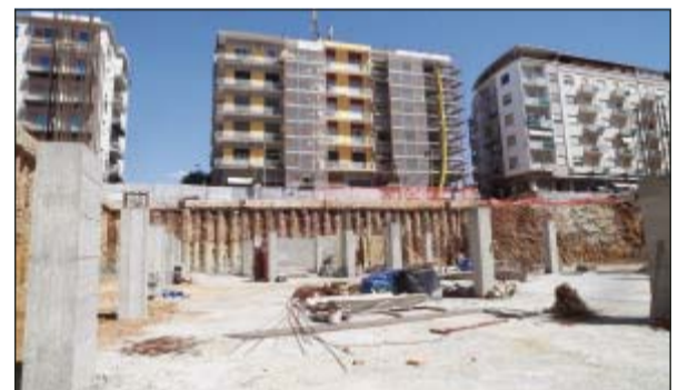
I lavori in corso a piazza Bilotti
