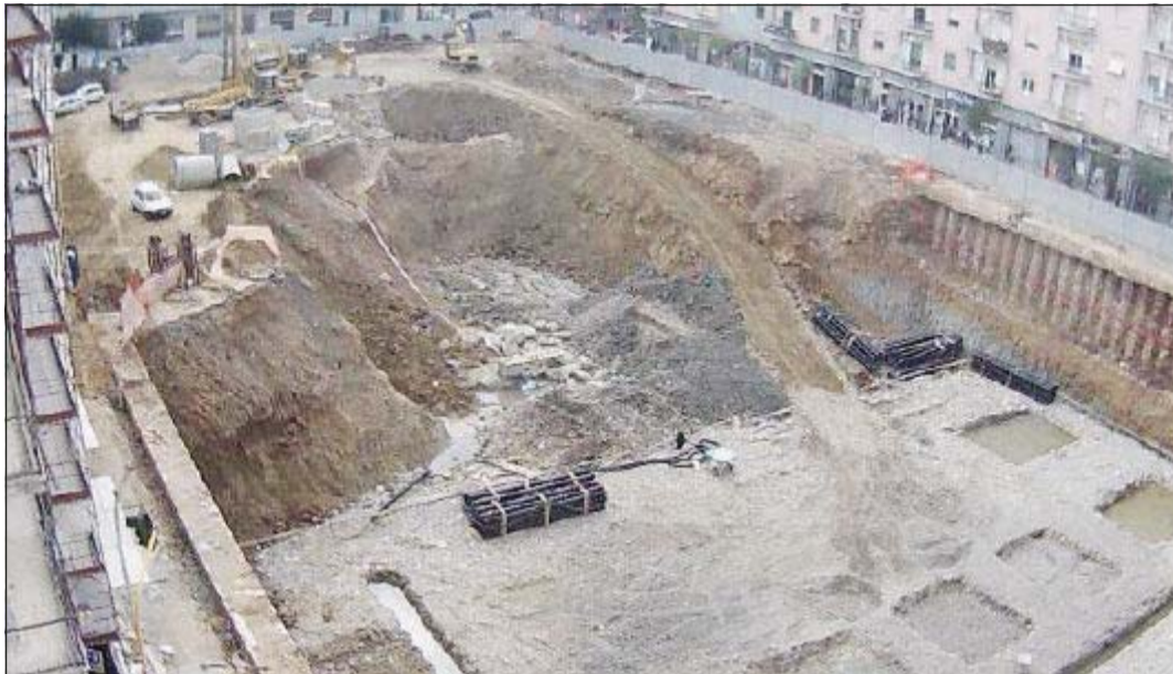
Il cantiere di piazza Bilotti visto ieri alle 12.25 dalla webcam
