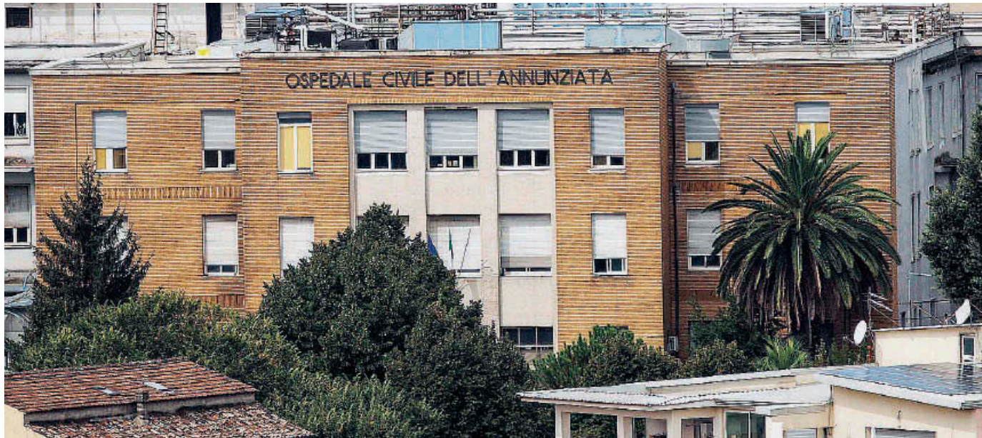
Ospedale civile dell'Annunziata. Il nosocomio presenta in più gravi lacune strutturali
